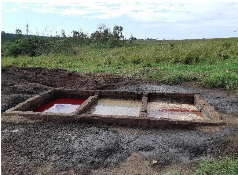
*Caixa de entrada separadora com vazamento de sobrenadante*
